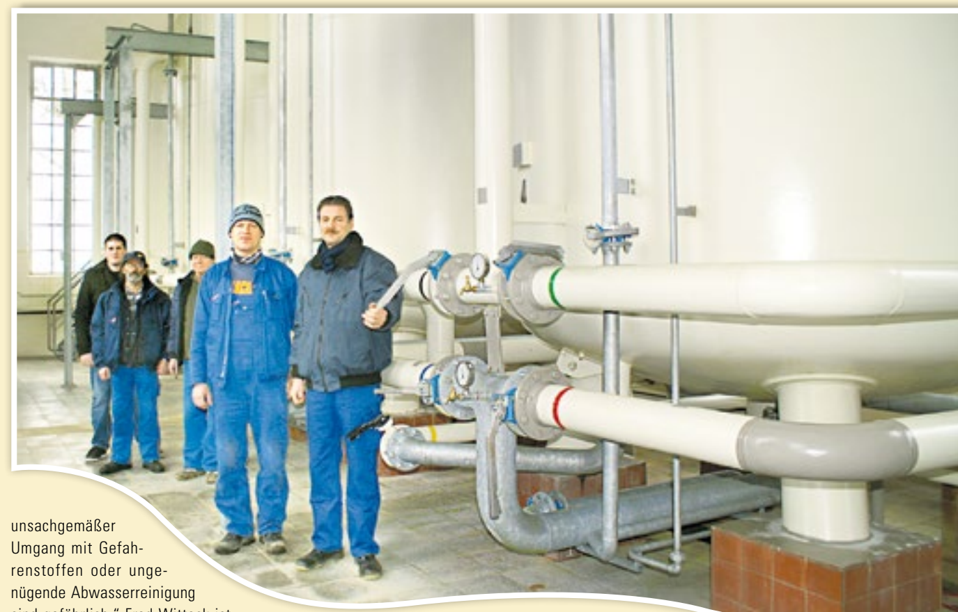
Die Kollegen Patrick Pogrzeba, Reiner Gennrich, Peter Burat, Ralph Knop und Wassermeister Fred Witteck (v.l.) kümmern sich mit drei weiteren im Team um den störungsfreien Ablauf der Trinkwasserversorgung.
