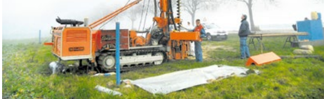
In der Ortslage Pritzler werden neue Trinkwasser-Brunnen gebaut.
