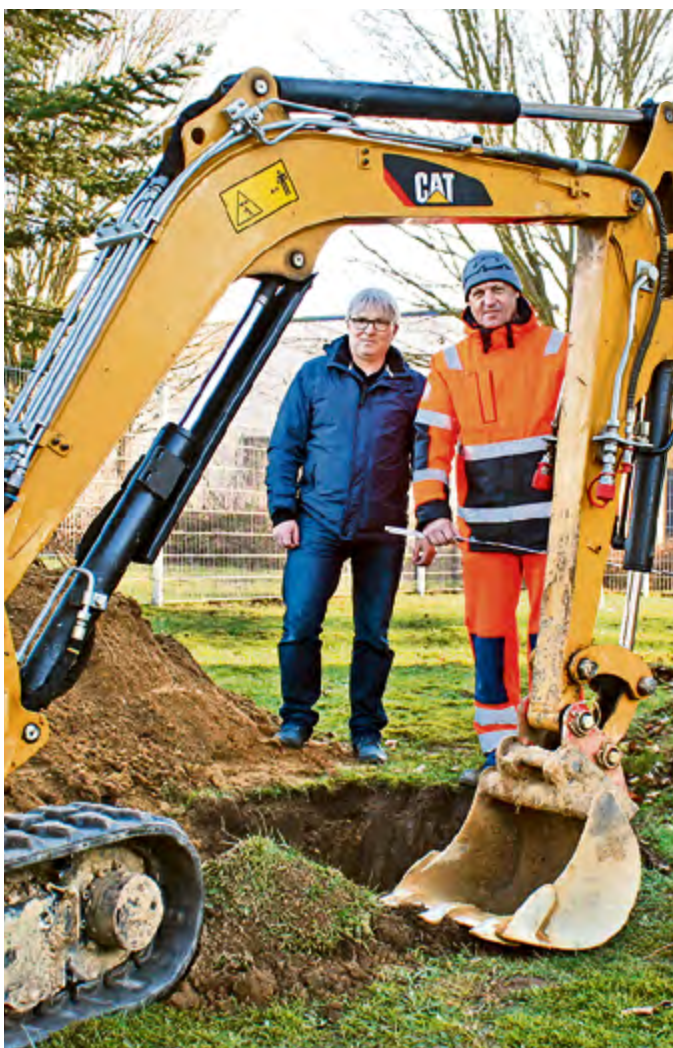
Christian Zschiesche (li.), Technischer Geschäftsführer, und Vorarbeiter Ralf Knop begutachten den Baufortschritt an der Druckstation Schanzberg. Hier wird die Sanierung 2020 in Teilabschnitten fortgesetzt.
