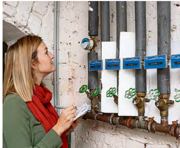
Wer selbst abliest, ist schneller fertig! In Pandemie-Zeiten fanden 92 Prozent der Zählerstände den Weg in den ZV. Foto: SPREE-PR/Arndt
