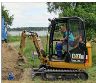
Olaf Segebrecht beim Bagger-einsatz. Foto: Zweckverband Wolgast
