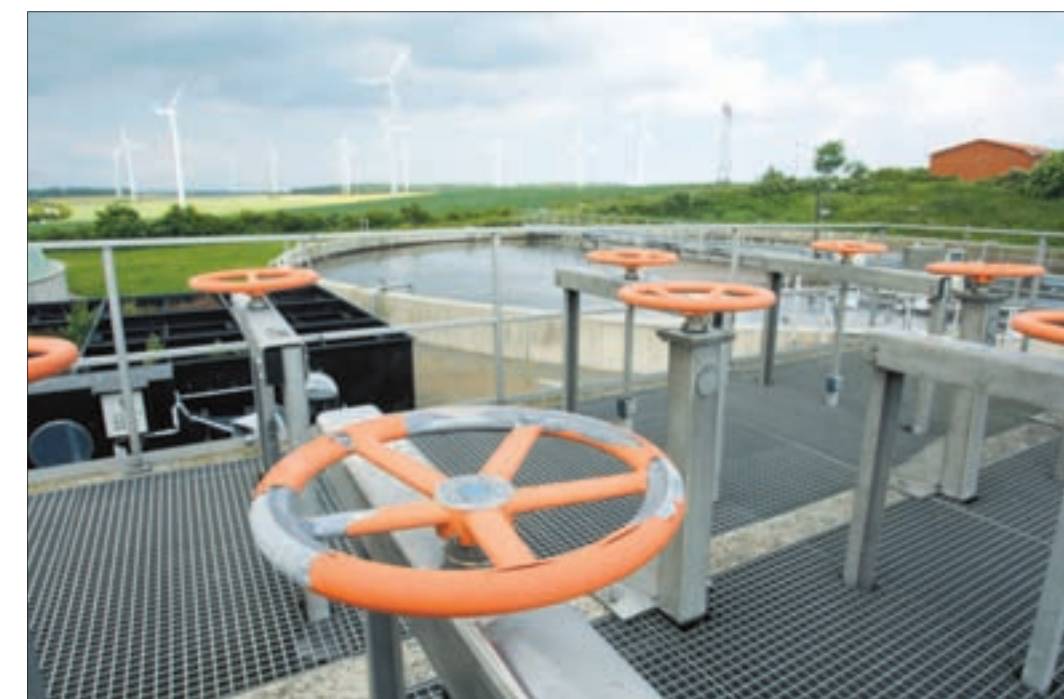
Die Auslastung der Kläranlage Wolgast ist bis zum Jahr 2026 gesichert.
